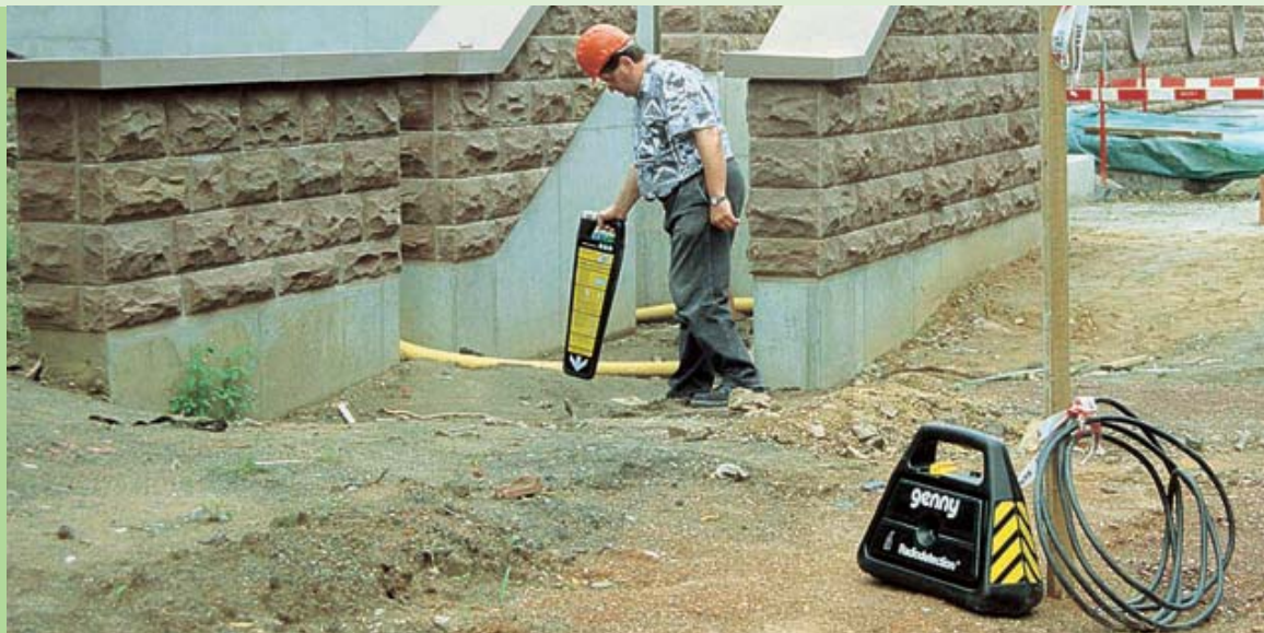
Leitungssuche mit Ortungsgerät.
