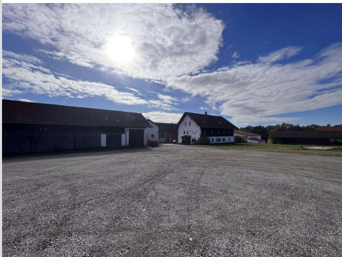
Blick von Nord aufs Grundstück
