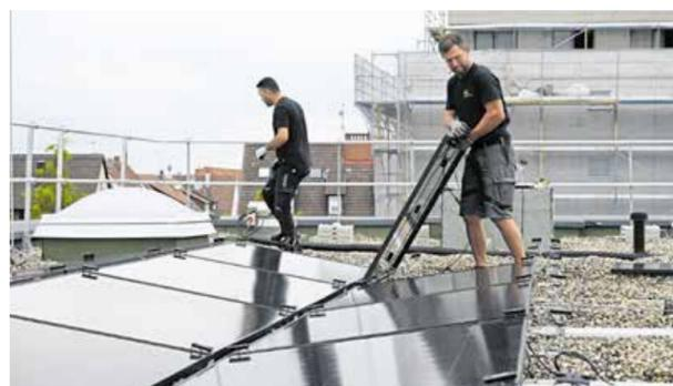
Mitarbeiter von Widmann Energietechnik haben 210 Photovoltaik-Module auf dem Dach der Handwerkskammer montiert.
