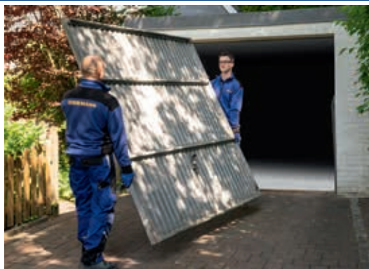
Ausbau und umweltgerechte Entsorgung
