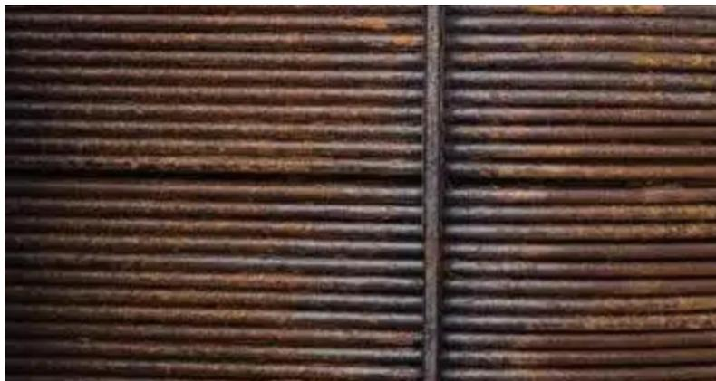
Verstopftes und korrodiertes Wärmetauscherbündels
