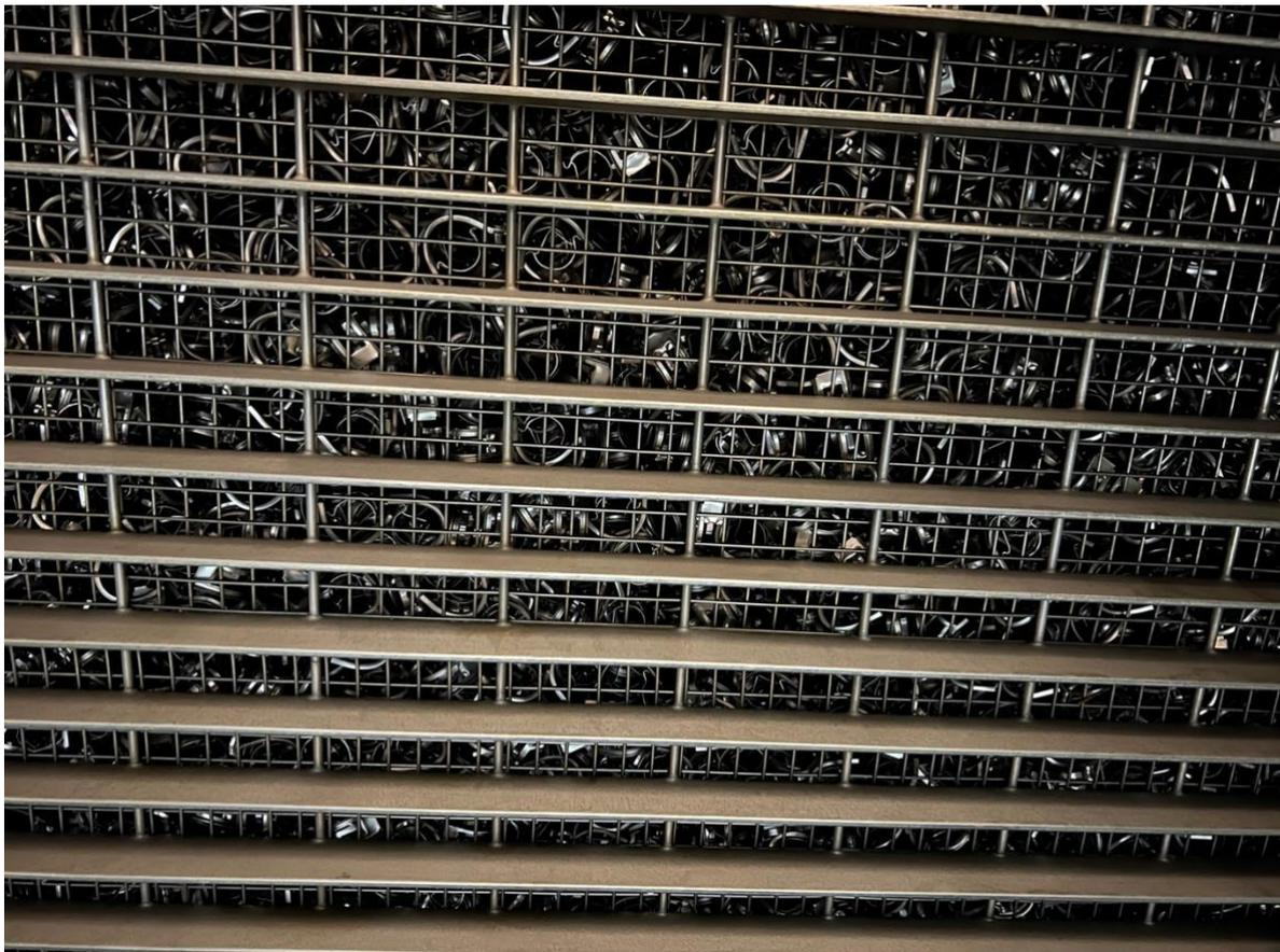
Das Bild zeigt die Wäscherpackung (Edelstahlkörper) von unten.
