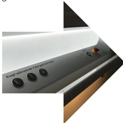
Die Etagentasten, Nothalteknopf, Alarmtaste sowie Angaben zu maximal zulässigen Traglast, befinden sich ebenfalls auf dem Innentableau.
