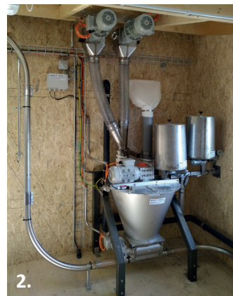
2. Im separaten Anmischbehälter werden die Komponenten per Waage genau eingefüllt und gemischt. Sämtliche produktberührende Teile sind aus Edelstahl V2A oder aus verschleißfestem Stahl gefertigt. Eine elektropneumatische Doppelklappe entleert den Behälter sekunden-schnell in den darunter installierten Ausdosierbehälter. Sobald der Anmischbehälter leer ist, beginnt die nächste Mischung. Für höchste Genauigkeit bei der Zubereitung der Mischungen arbeitet die Waage mit einer Genauigkeit von 10 Gramm.
