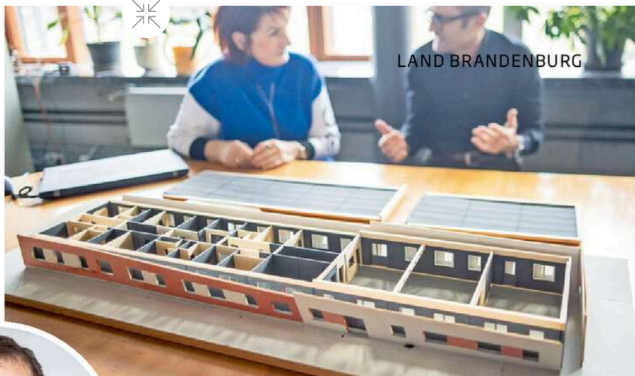
Gebrauchte Platten aus dem DDR-Wohnungsbau werden für ein Vereinsheim verwendet. Die ECOSOIL Ost GmbH hat die Platten behutsam abgetragen, die BTU Cottbus hat den Neubau konzipiert.
