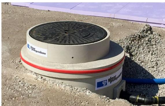
Die Abdichtung gegen die Bodenplatte erfolgt mit einem quellfähigen Dichtungsband (SikaSwell).
