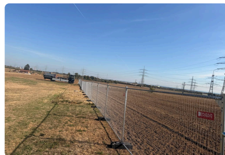
Zauntrasse im Freileitungsbau
