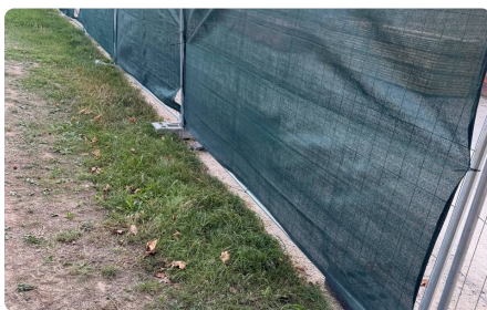
Mit Sichtschutznetz und Bauzaunfüßen
