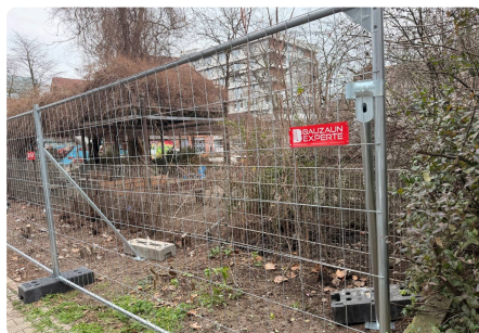
Stützstrebe mit Fußplatte, mit Recyclingfuß beschwert
