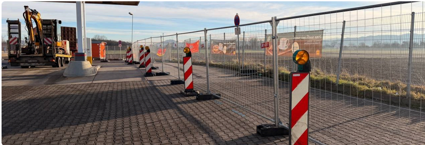
M400 mit Bauzaunfüßen als Baustellenabspernung
