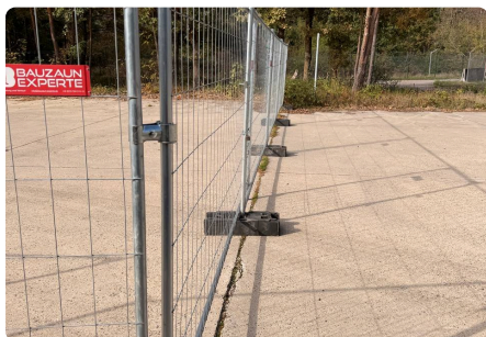
Ecke mit Verbindungsschelle und Recyclingfüßen
