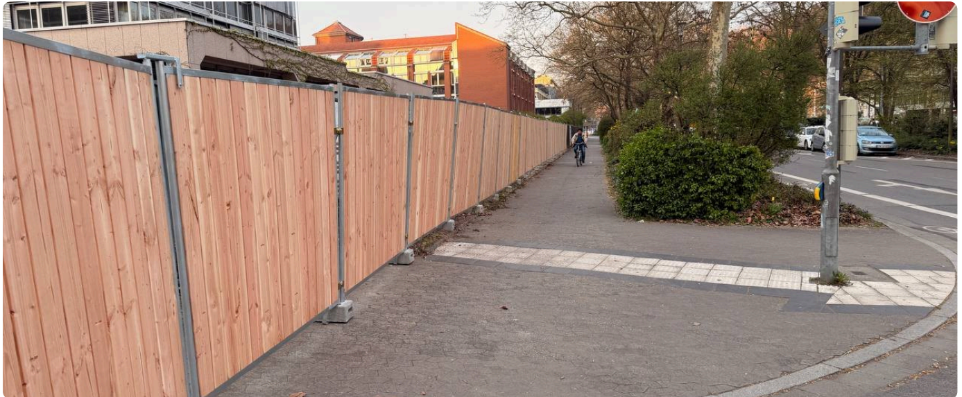
M800 entlang des Gehwegs – Aufbau wie ein Bauzaun, Optik wie ein Bretterzaun
