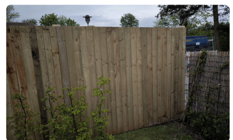
Einbetonierte Ausführung am Spielplatz
