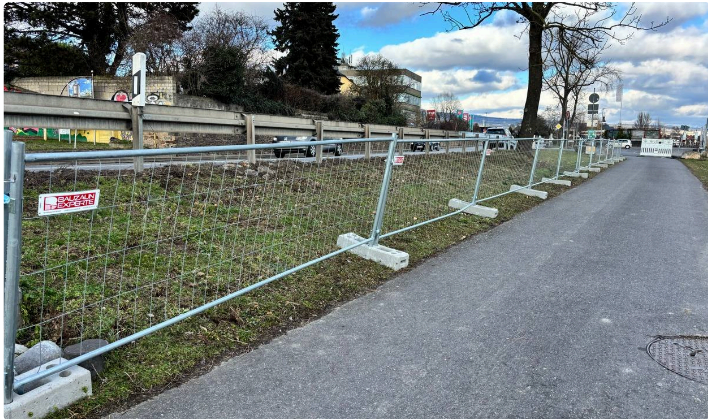
M100 als Abtrennung zwischen Radweg und Baufeld
