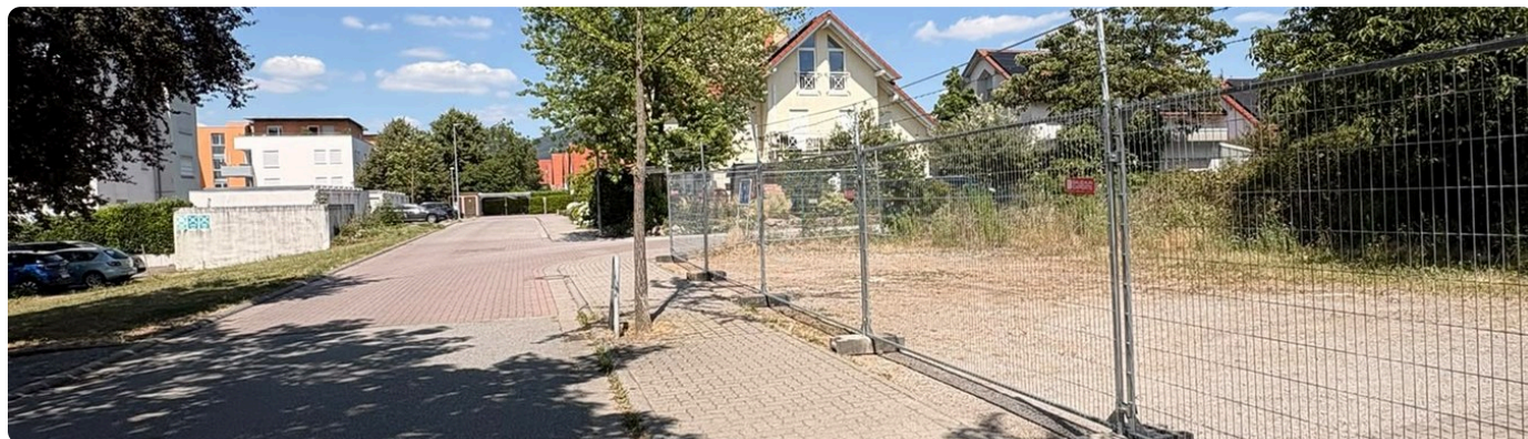
M500 Anti-Climb mit Recyclingfüßen an einer Wohnanlage
