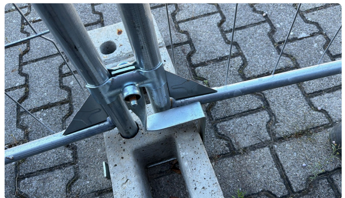
Aushebesicherung am Betonfuß
