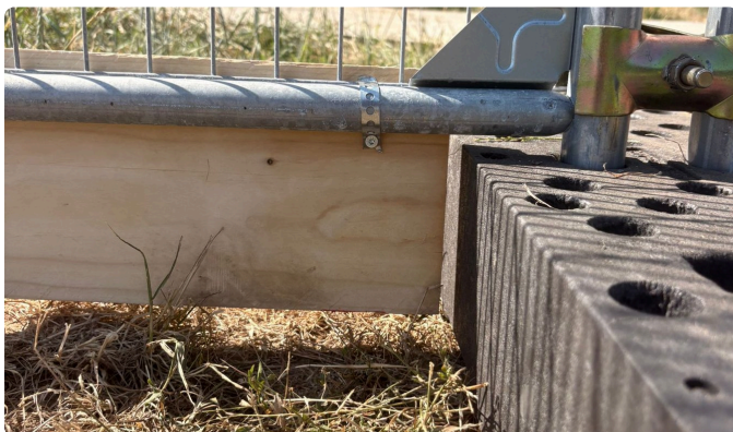
Unterkriechschutz: Holzbohle am Fuß
