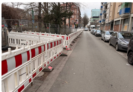
Absperlinie mit Fußplatten entlang der Straße
