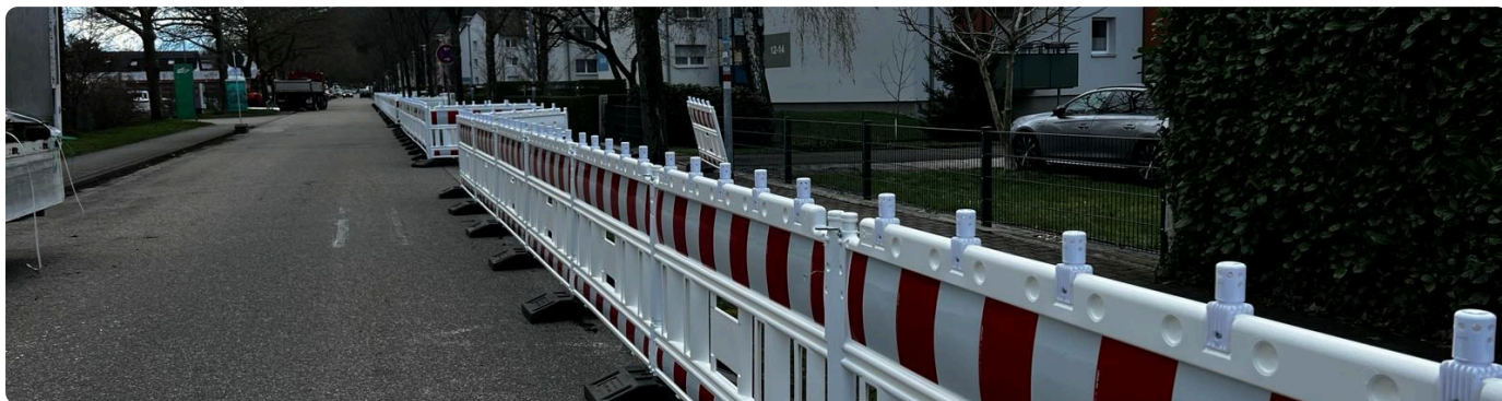
Absperrschranken auf TL-Fußplatten K1 als Längsabspernung an einer Wohnstraße
