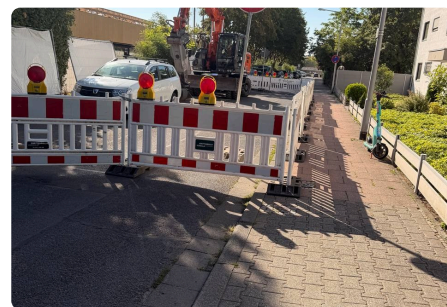
Straßensperre mit Warnleuchten
