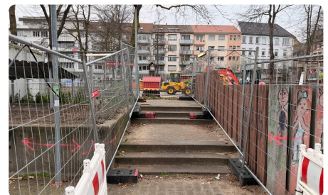
Korridor aus Bauzaun und Absperrschranken
