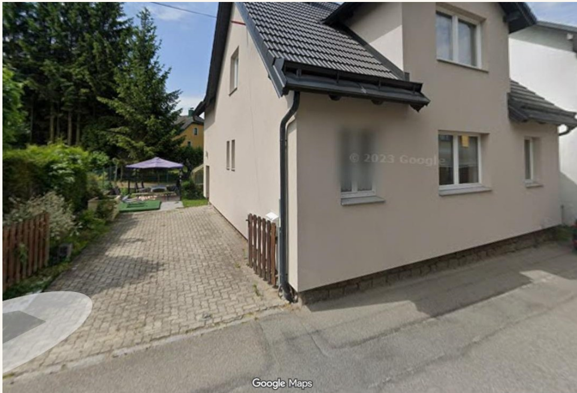
Außenansicht Einfamilienwohnhaus Angergasse 4
