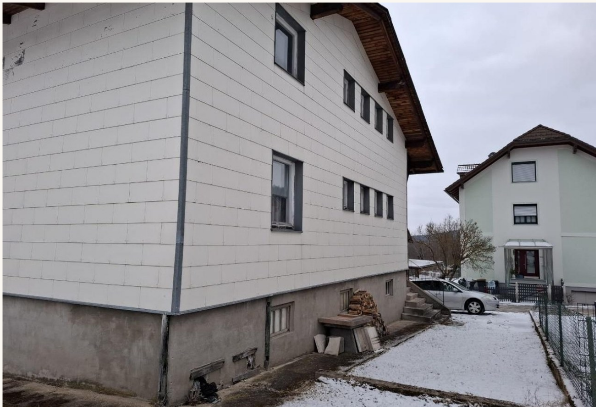
Außenansicht Einfamilienhaus Bad Großpertholz 203
