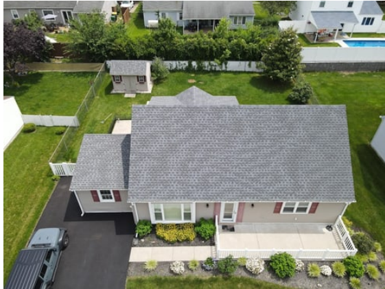
Luftaufnahme des Grundstücks
