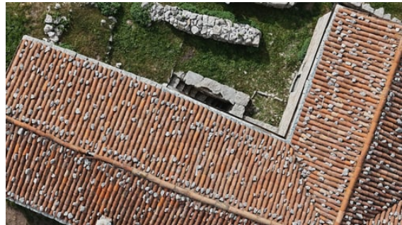
Dach aus der Vogelperspektive
