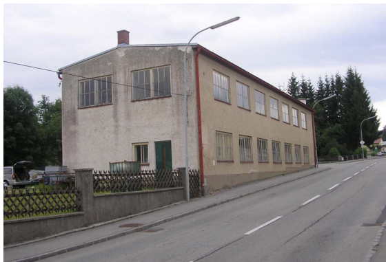
Seitenansicht entlang der Straße
