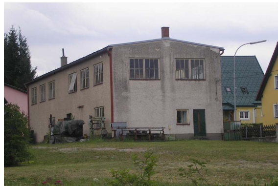
Rückansicht mit Freifläche
