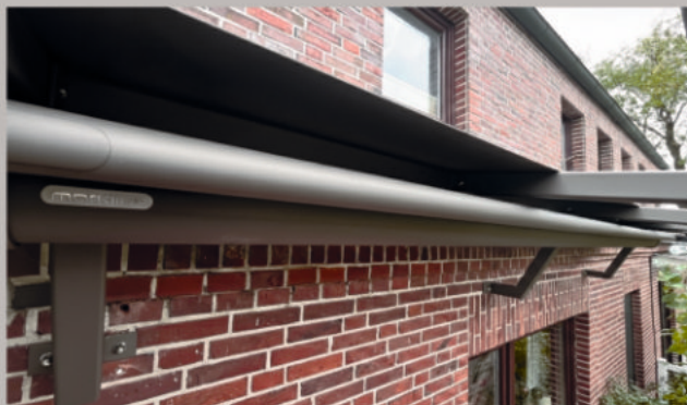
Abschlussblech als Wetterschutz – die Markise ist sauber geschützt
