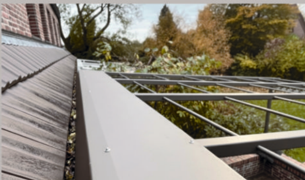
Anschluss an die Dachrinne – Wasser läuft zuverlässig ab
