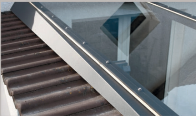
Anschluss an Dachfläche – Wasserführung mit sauberer Überdeckung
