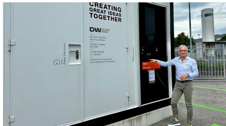
*Stromspeicher mit integriertem Ladeport (900kWh Speicher, 2 x 420kW Charger)*
