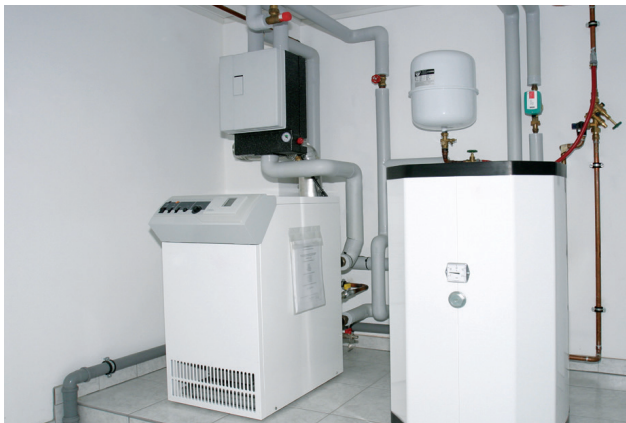
Ohne Geysir: Sanitäranlagen setzen unsichtbar Kalkstein an
