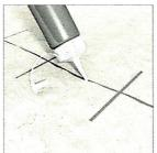
3. Ausgussnase aufschneiden und Riss mit Klebamer RH verfüllen.
