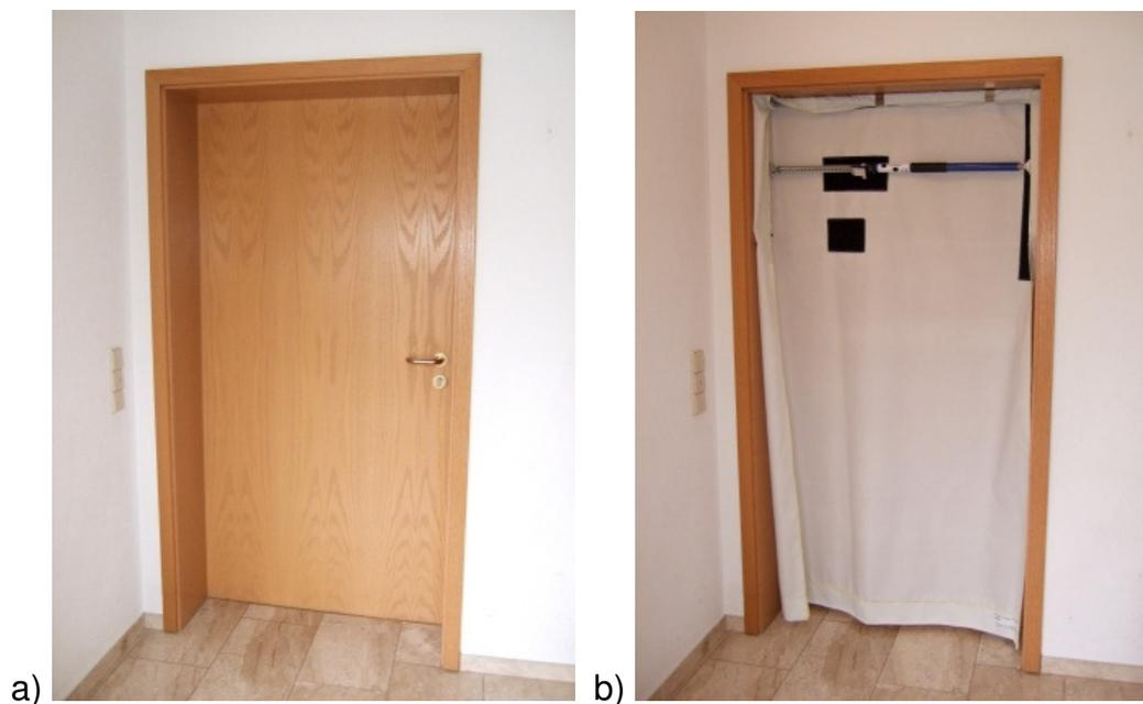
**Bild 10: mobiler Rauchverschlusses für die Feuerwehr**
