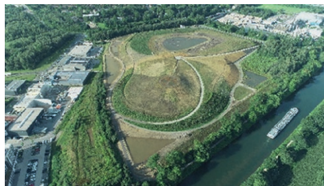
Fig. 3. Site of the former Graf Bismarck coking plant. // Bild 3. Gelände der ehemaligen Kokerei Graf Bismarck. Source/Quelle: ECOSOIL
