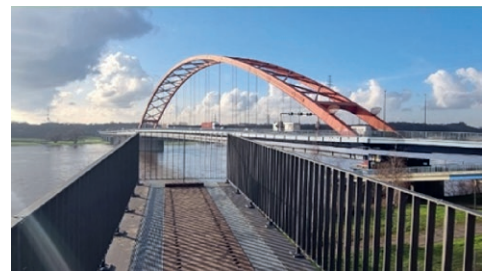
Fig. 4. Duisburg RheinPark redevelopment project. // Bild 4. Sanierungsprojekt Duisburg RheinPark. Source/Quelle: ECOSOIL
