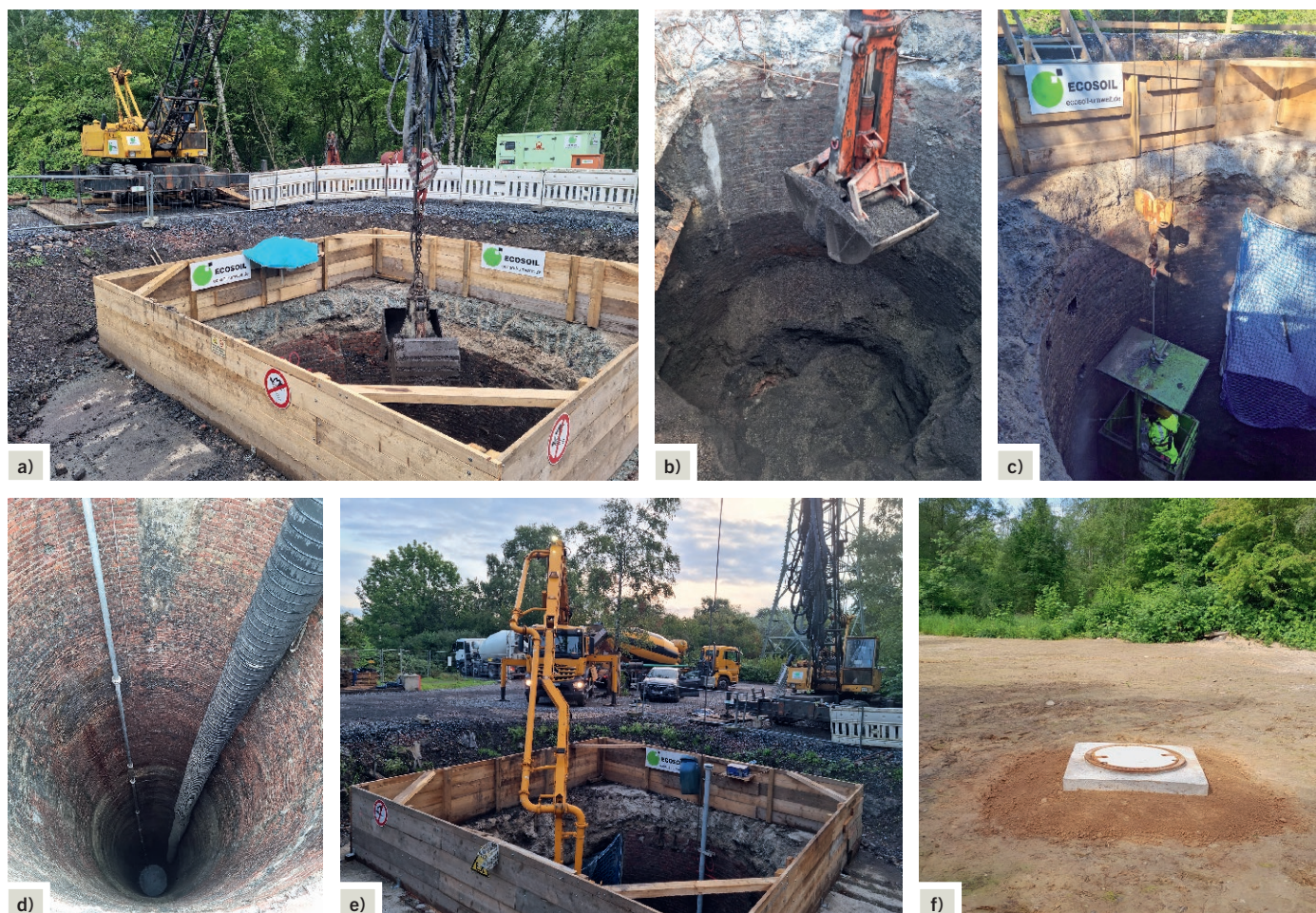
Fig. 1. a) and b) clearing, c) cleaning the shaft wall, d) installing the filter gravel layer, e) filling the shaft column with hydraulically setting building material and f) sealing the degasification line. // Bild 1. a) und b) Beräumung, c) Reinigung der Schachtwandung, d) Einbau der Filterkiesschicht, e) Restauffüllung der Schachtfüllsäule mit hydraulisch abbindendem Baustoff und f) Verschluss der Entgasungsleitung. Photos/Fotos: ECOSOIL
