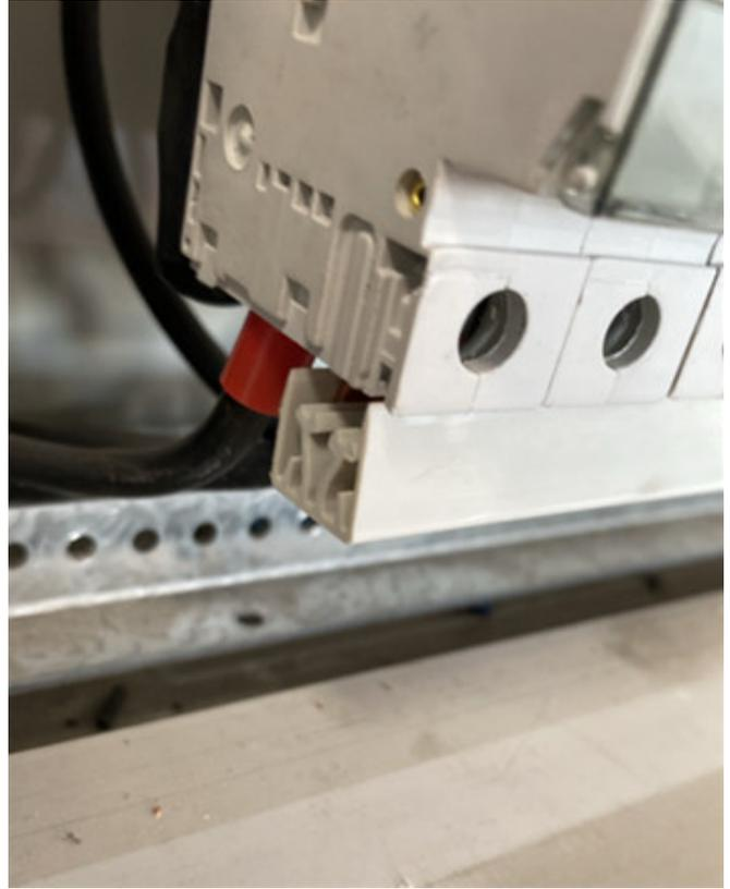
Bild 6: Fehlende Endkappe an Phasenschiene
