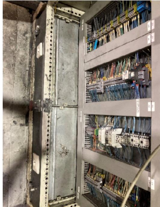
Bild 2: Erhöhter Verschmutzungsgrad.
