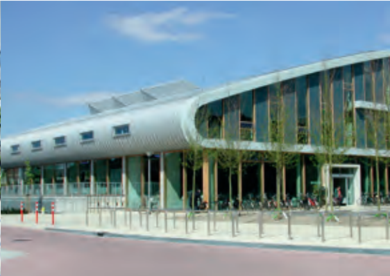
❖ Kulturzentrum // Niederlande Anwendung: Kultur Profil: N65 - 400 Material: Aluminium 1,0 mm Farbe/Oberfläche: RAL 9006 / PVDF Fläche: 2 250 m²
