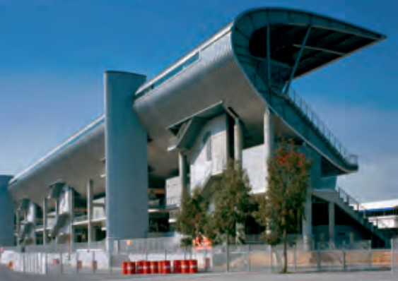
Formel 1 Tribüne // Spanien Anwendung: Sport Profil: N65 - 400 Material: Aluminium 1,0 mm Farbe/Oberfläche: Walzblank Fläche: 17 000 m²
