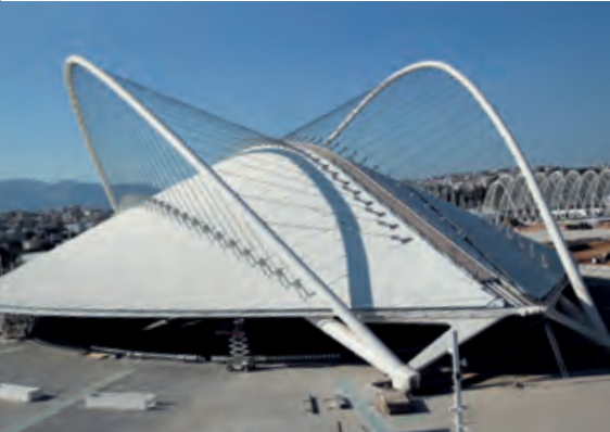
Velodrom // Griechenland Anwendung: Sport Profil: N65 - 400 Material: Aluminium 1,0 mm Farbe/Oberfläche: RAL 9010 / PVDF Fläche: 11 500 m²
