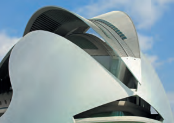
Oper Valencia // Spanien Anwendung: Kultur Profil: N65 - 400 Material: Aluminium 1,0 mm Farbe/Oberfläche: Stucco Fläche: 3 600 m²
