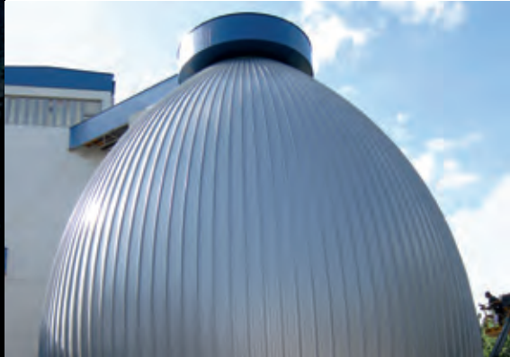
❖ Faulturm // Österreich Anwendung: Kläranlage Profil: BEMO-MONRO® Material: Aluminium 1,0 mm Farbe/Oberfläche: RAL 9006 / PE Fläche: 1 000 m²
