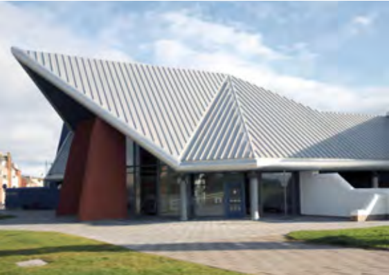
Besucherzentrum // Schottland Anwendung: Freizeit Profil: N65 - 400 Material: Aluminium 0,9 mm Farbe/Oberfläche: Stucco Fläche: 1 750 m²
