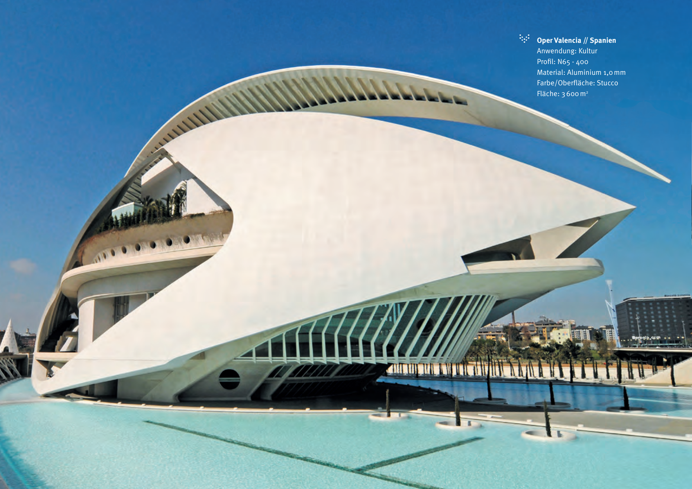
Oper Valencia // Spanien Anwendung: Kultur Profil: N65 - 400 Material: Aluminium 1,0 mm Farbe/Oberfläche: Stucco Fläche: 3 600 m²
