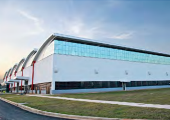
❖ SEW Eurodrive // Brasilien Anwendung: Industrie Profil: N65 - 400 Material: Galvalume 0,65 mm Farbe/Oberfläche: Natur Fläche: 30 000 m²
