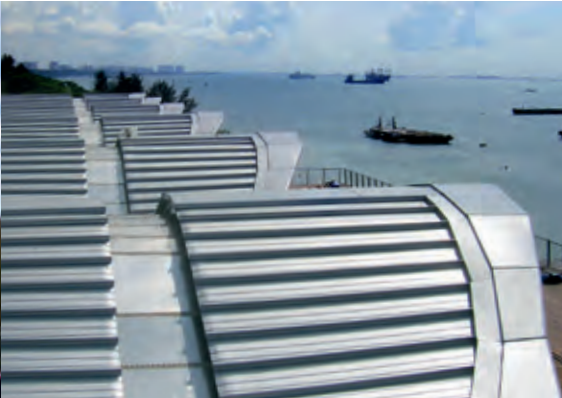
❖ Clifford Pier // Singapur Anwendung: Hafenpier Profil: N65 - 400 Material: Aluminium 1,0 mm Farbe/Oberfläche: RAL 9006 / PVDF Fläche: 3 000 m²
