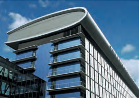
Universität // Niederlande Anwendung: Bildung Profil: N65 - 400 Material: Aluminium 1,0 mm Farbe/Oberfläche: Stucco Fläche: 5 300 m²
