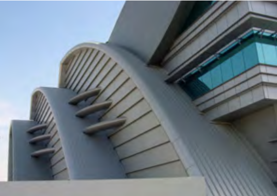
Dubai Flower Center // VAE Anwendung: Handel Profil: N65 - 400 Material: Aluminium 1,0 mm Farbe/Oberfläche: RAL 9006 / PVDF Fläche: 13 000 m²
