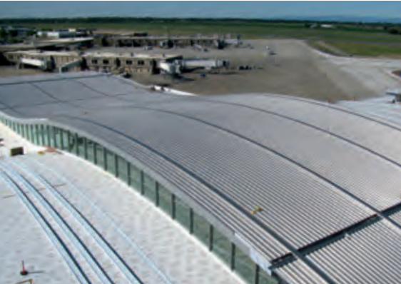
Sacramento International // USA Anwendung: Flughafen Profil: N65 - 400 Material: Edelstahl 0,85 mm Farbe/Oberfläche: III C Fläche: 19 000 m²
