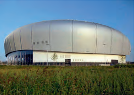
❖ ISS Dome // Deutschland Anwendung: Sport Profil: BEMO-MONRO® Material: Aluminium 1,0 mm Farbe/Oberfläche: RAL 9006 / PE Fläche: 8 000 m²
