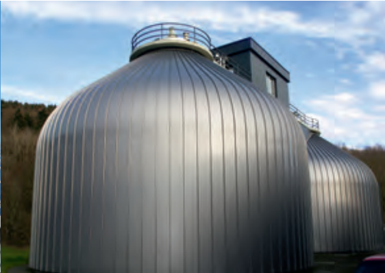
❖ Faulturm // Deutschland Anwendung: Kläranlage Profil: BEMO-MONRO® Material: Aluminium 1,2 mm Farbe/Oberfläche: RAL 9007 / BEMO-FLON Fläche: 850 m²
