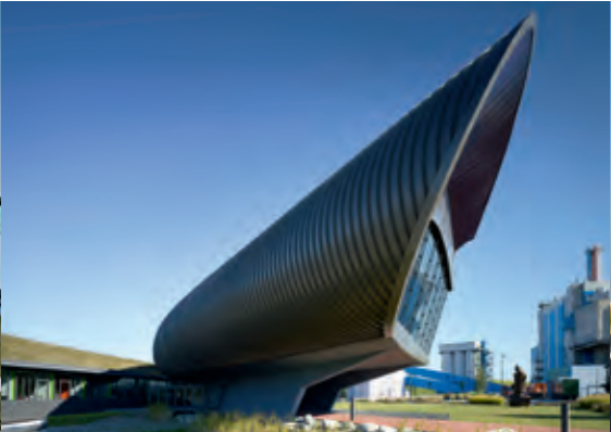
❖ Verwaltungsgebäude // Deutschland Anwendung: Industrie Profil: BEMO-MONRO® Material: Aluminium 1,0 mm Farbe/Oberfläche: RAL 7048 / PVDF Fläche: 1200 m²
