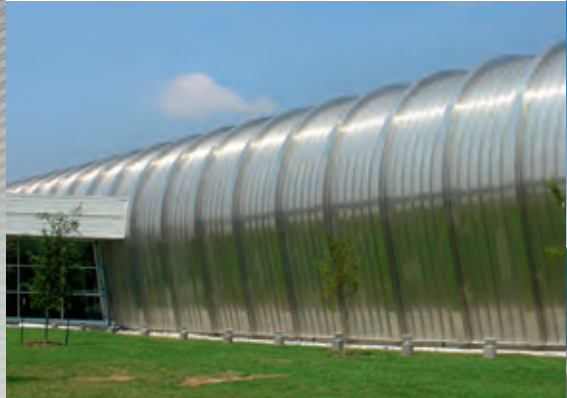
Veranstaltungshalle // USA Anwendung: Sport Profil: N65 - 400 Material: Aluminium 1,0 mm Farbe/Oberfläche: Walzblank Fläche: 22 300 m²
