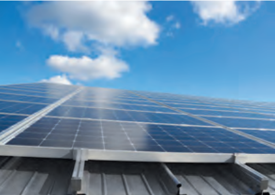
❖ Solardach // Deutschland Anwendung: Industrie Profil: VF65 - 422, BEMO-AKKORD Material: Aluminium 0,8 mm Farbe/Oberfläche: Stucco Fläche: 6 400 m²
