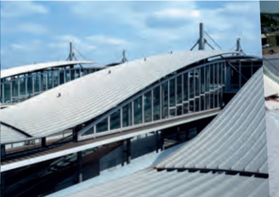
Bahnhof // Deutschland Anwendung: Infrastruktur Profil: N65 - 333 Material: Aluminium 1,0 mm Farbe/Oberfläche: Stucco Fläche: 6 000 m²
