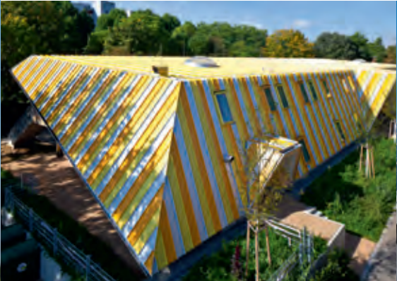
❖ Kindergarten // Deutschland Anwendung: Bildung Profil: N65 - 500 Material: Aluminium 1,0 mm Farbe/Oberfläche: RAL 9006, NCS S 1060-y 20R, NCS S 0560-y / BEMO-FLON Fläche: 1 200 m²
