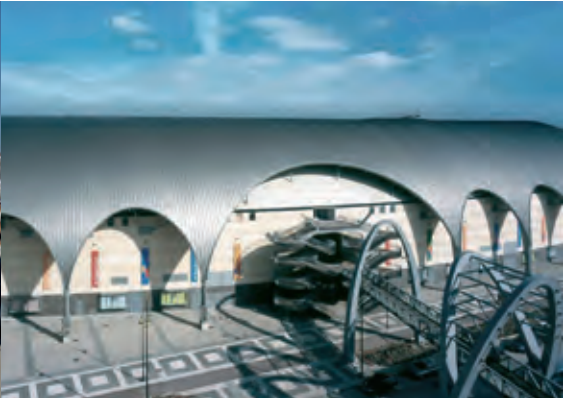
Einkaufszentrum // Spanien Anwendung: Handel Profil: BEMO-MONRO® Material: Aluminium 1,0 mm Farbe/Oberfläche: Titanoptik / PUR/PA Fläche: 5 000 m²
