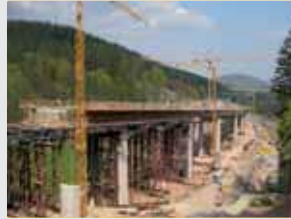
Talbrücke Mönchröden 96472 Rödental
