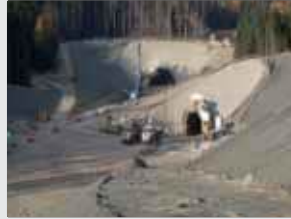
Tunnel Höhnberg / Füllbach 96489 Niederfüllbach
