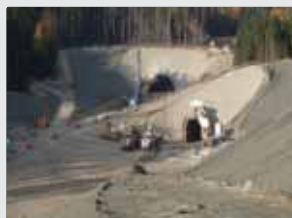
Tunnel Höhnberg / Füllbach 96489 Niederfüllbach
