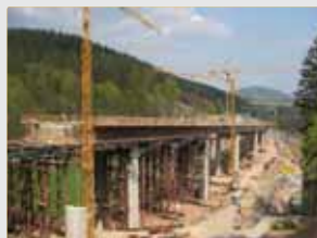
Talbrücke Mönchröden 96472 Rödental
