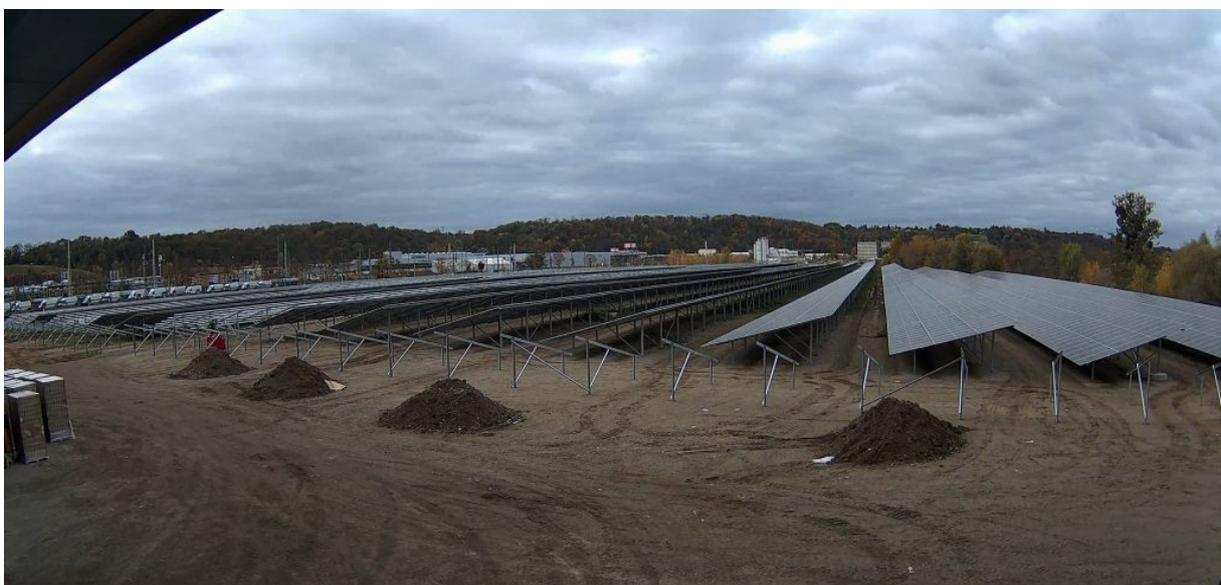
**September 2024:** Die Unterkonstruktion der PV-Freiflächenanlage steht kurz vor der Fertigstellung, die Modultische mit Ausrichtung Ost und West werden noch angebracht. Es wurden bereits mehr als 1.000 Module montiert. Die Hochwasserschutzwand ist ebenfalls fast fertig. Des Weiteren wurden die Gräben für die AC-Verkabelungen von den Wechselrichtern zu den Trafostationen gezogen.
