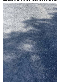
Zahorra artificial compactada
