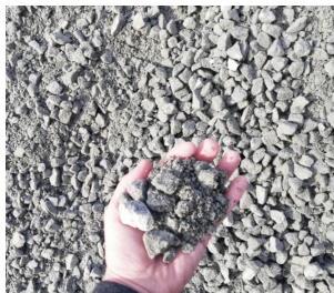
Grave concassée / couche de fondation minérale
