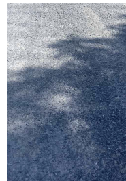
Couche de fondation minérale compactée
