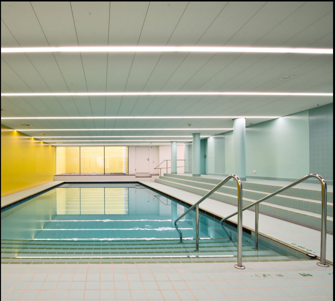
Basel - Dalbenhof Deckenbekleidung - Mikropor-G, Strukturlack
