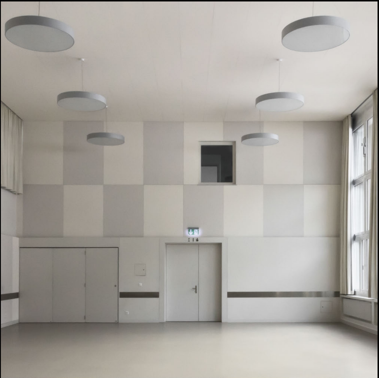
Andeer- Mehrzweckhalle Wand- und Deckenbekleidung - Akupor.H
