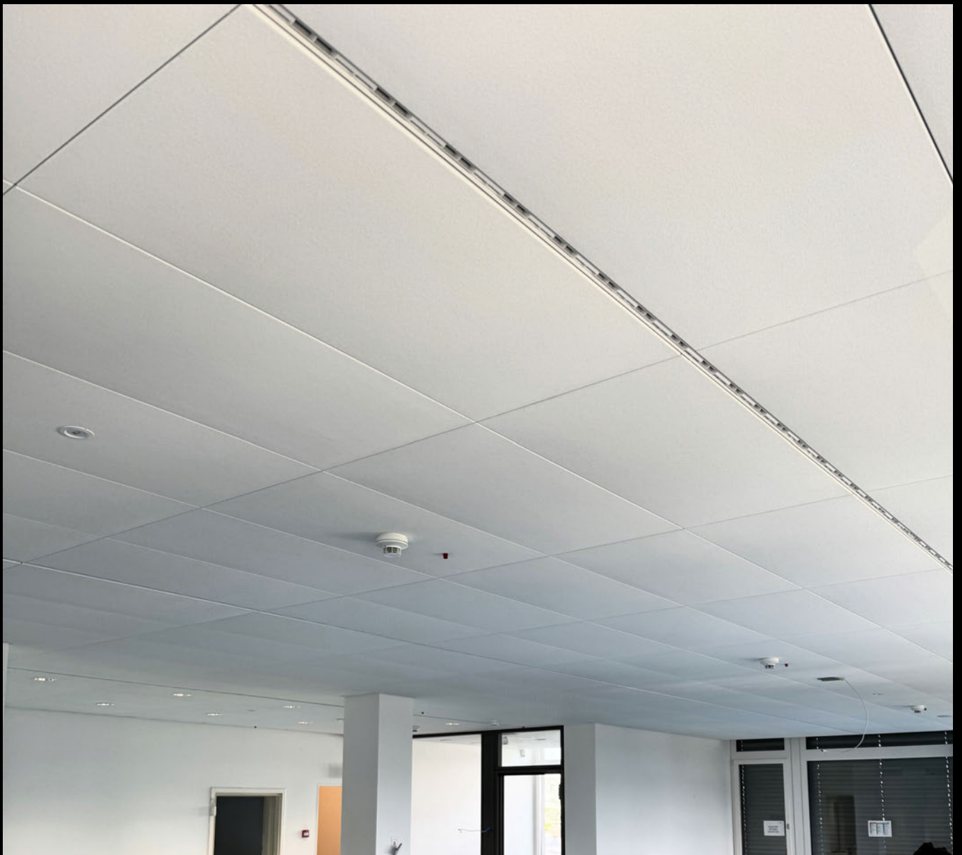
Luzern - Bürogebäude Deckenbekleidung - Metall-V, Strukturlack
