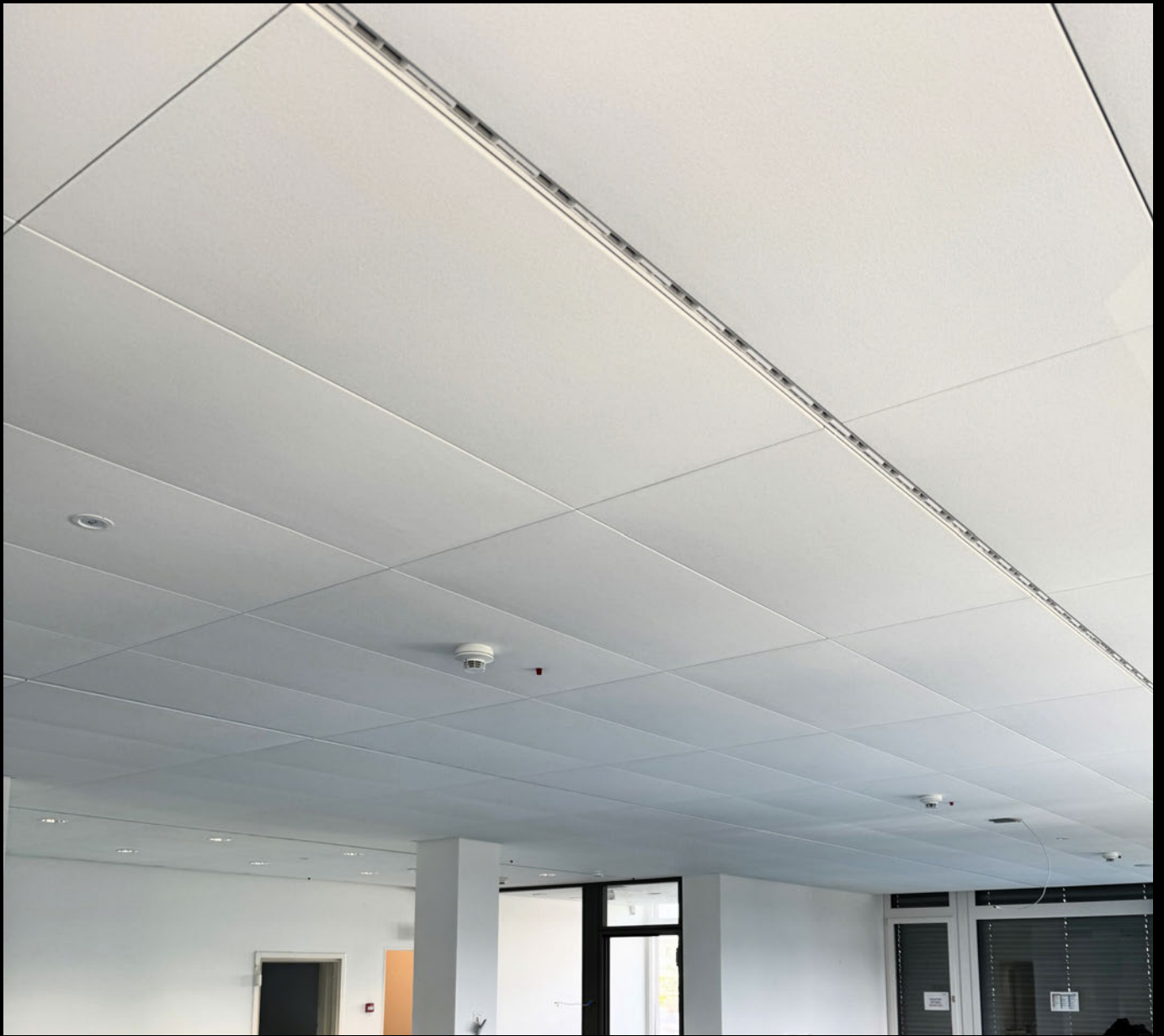
Luzern - Bürogebäude Deckenbekleidung - Metall-V, Strukturlack
