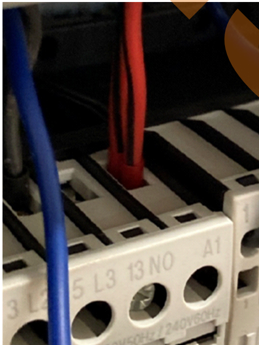
Bild 3: Doppelbelegung ohne Twin- Hülse.
