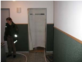
Blick vom Treppenraum auf die Tür zum Brandraum.
