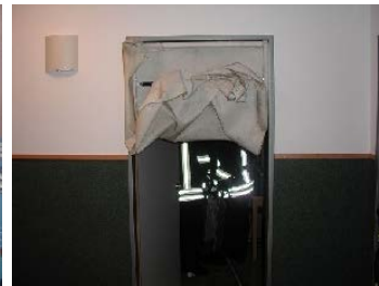
Endphase des Einsatzes; das Brandschutzgewebe ist über die Spannstange gehängt.
