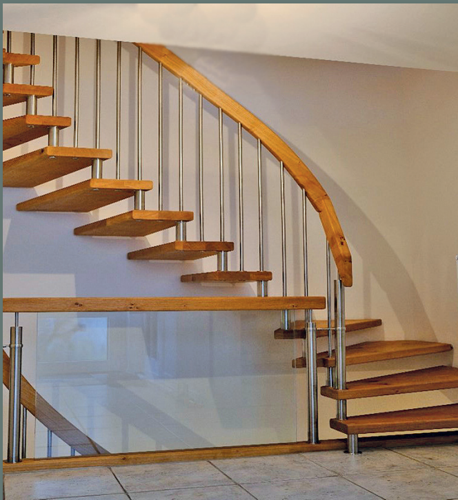
Freitragende Treppen strahlen Leichtigkeit aus und können mit vielen verschiedenen Geländerarten kombiniert werden.
