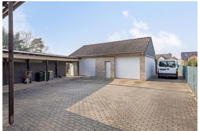
Doppelgarage im Hof
