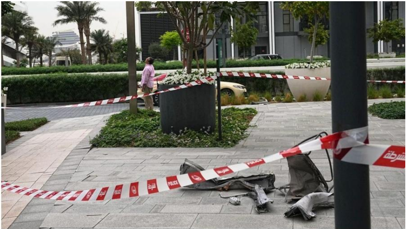
Die heruntergefallenen Trümmerteile eines angegriffenen Gebäudes am Boden, mit Flatterband abgesperrt
