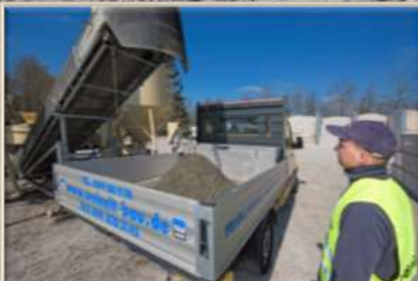
Herstellung von Frischbeton
