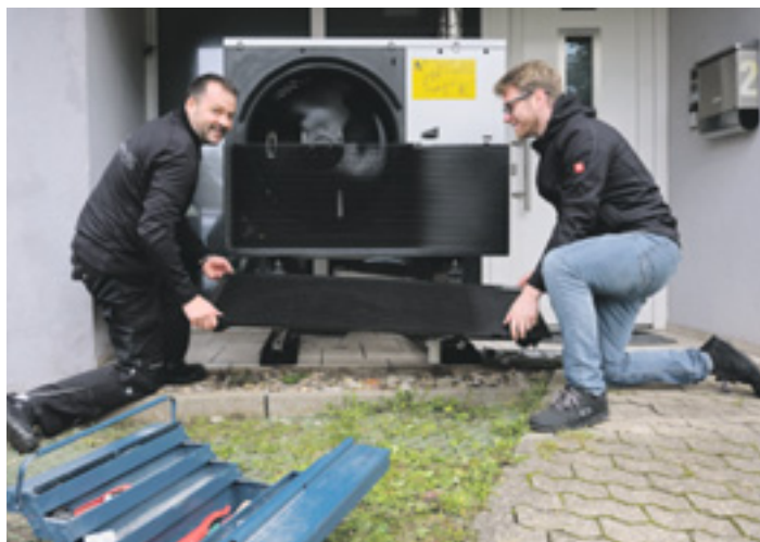
Montage einer Wärmepumpe.
